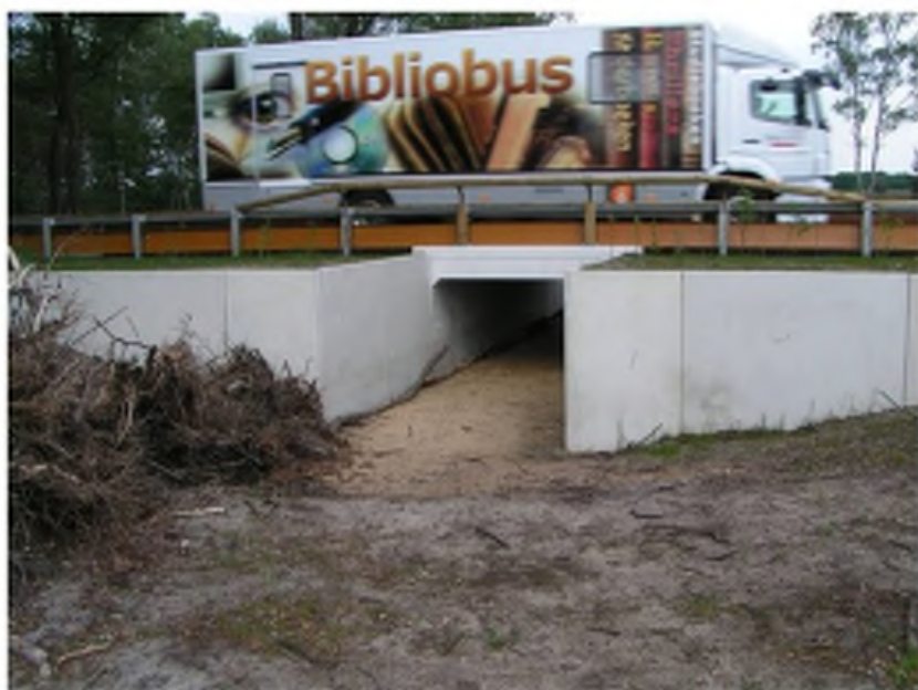
Afbeelding 13. De herpetoduct die tussen de deelgebieden Stakenberger Heide en Elspeetsche Heide is aangelegd.
