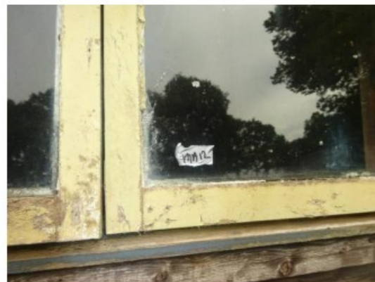
Monsternamelocatie MA12 (asbest niet aantoonbaar)
