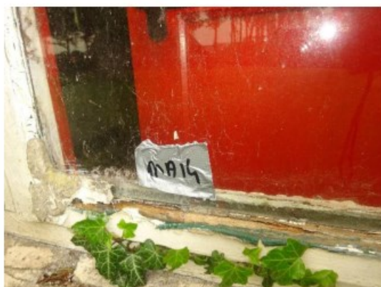
Monsternamelocatie MA14 (asbest niet aantoonbaar)
