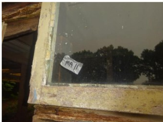
Monsternamelocatie MA11 (asbest niet aantoonbaar)
