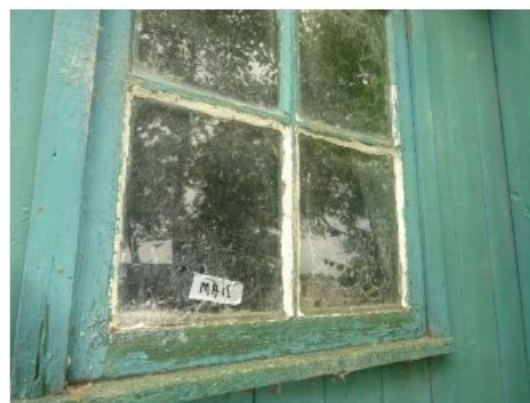
Monsternamelocatie MA15 (asbest niet aantoonbaar)
