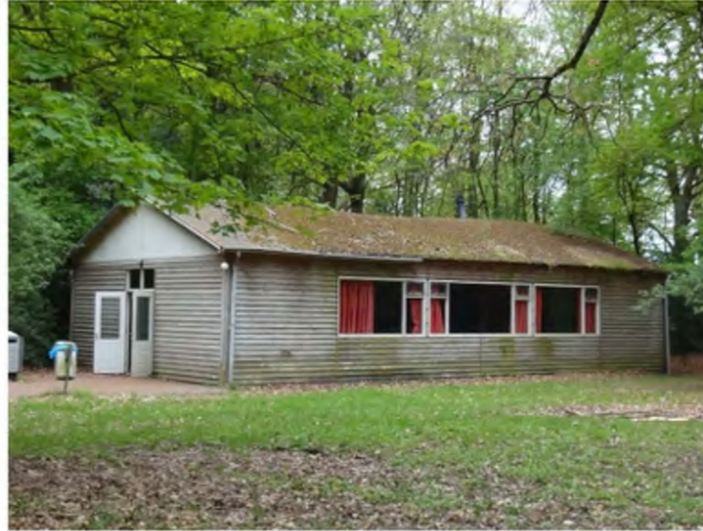
Te slopen opstal, voormalig jeugdverblijf.
