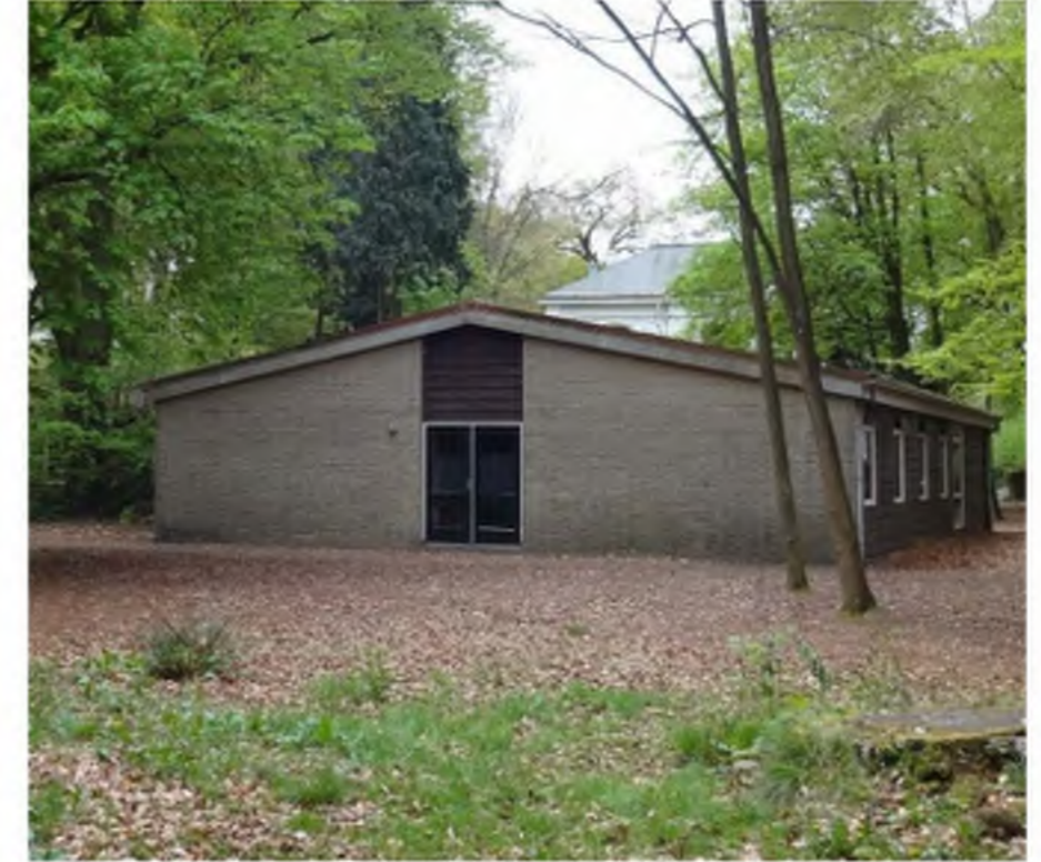
Te slopen opstal, voormalig jeugdverblijf.
