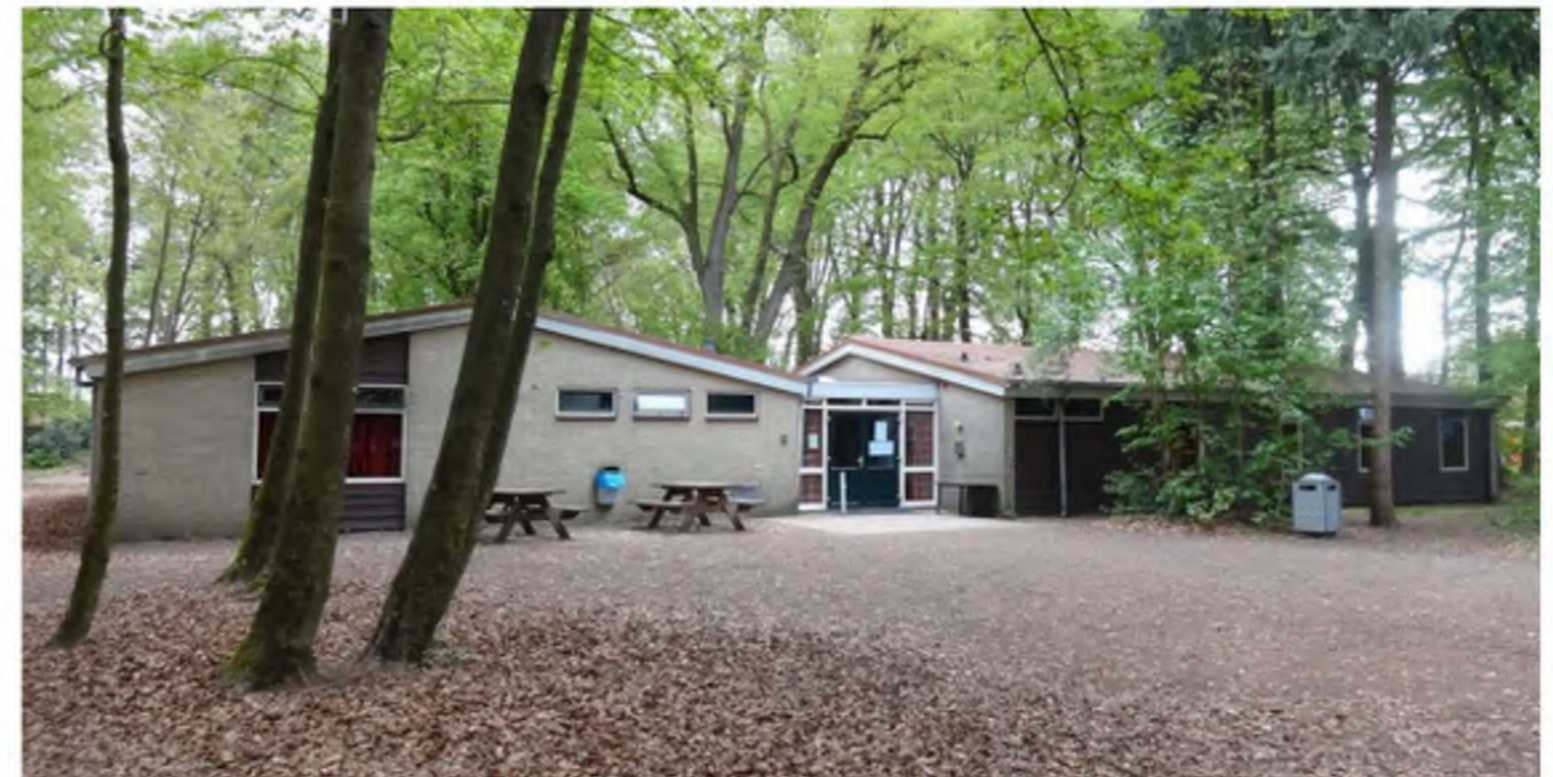
Te slopen opstal, voormalig jeugdverblijf.
