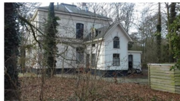
14) Oostzijde van het hoofdhuis met opslag van bomen en heesters. Hier staat een eenvoudig houten schuurtje/fietsenstalling.
