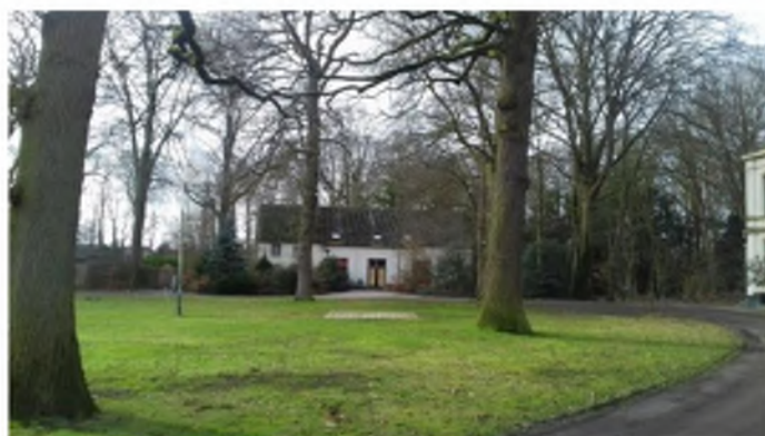
4) Het koetshuis gezien vanaf de oprolaan. In het gazon fraaie monumentale bomen.
