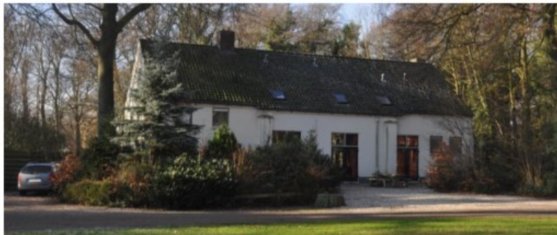
Het voormalige koetshuis met beheerders woning
