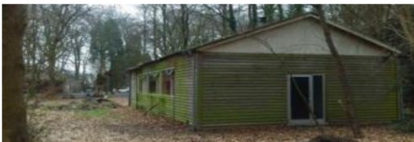
Het kleine groepsgebouw (inmiddels ingestort)
