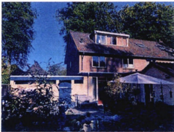
Afb. 3: foto achtergevel Boterdijk 13b (bron: [redacted])
