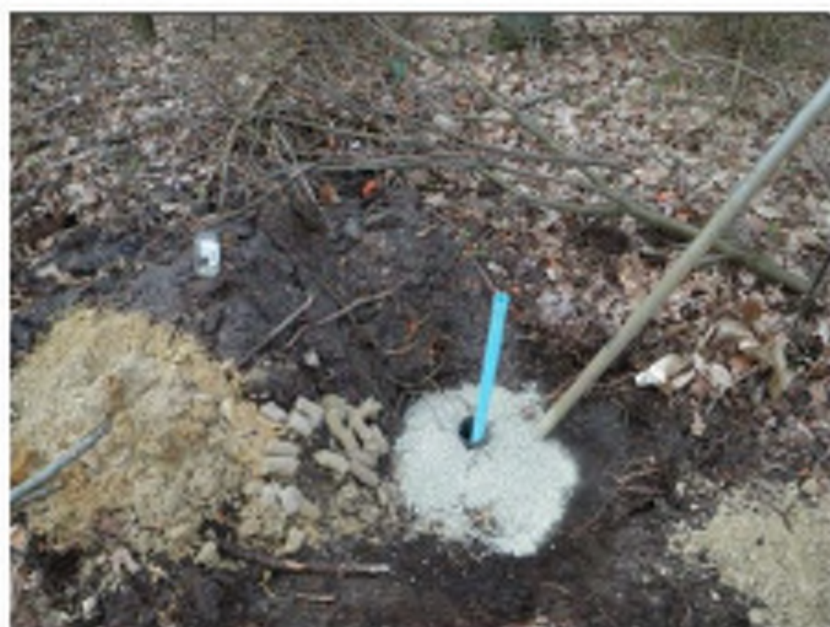
Foto b2.5 Peilbuis 101 met verloren casing
