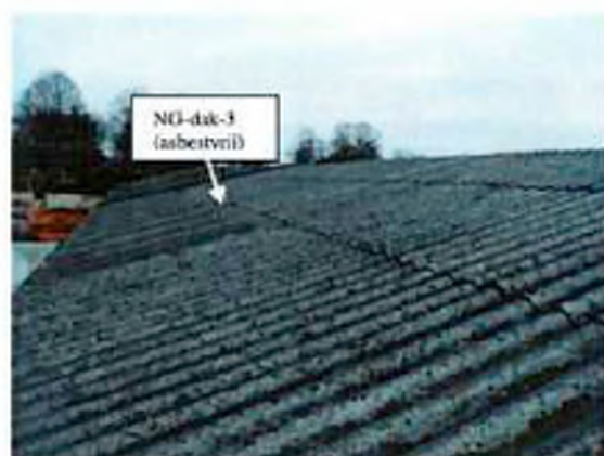
Foto 13: Asbestvrije golfplaat als gedeeltelijke dakbedekking van schuur 3. (NG-code)
