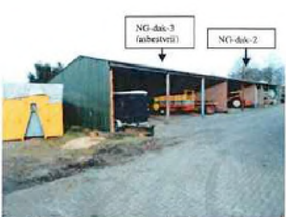
Foto 10: Geinventariseerde schuur 3 met asbesthoudende en asbestvrije golfplaat als dakbedekking vanuit oostelijke richting gezien.
