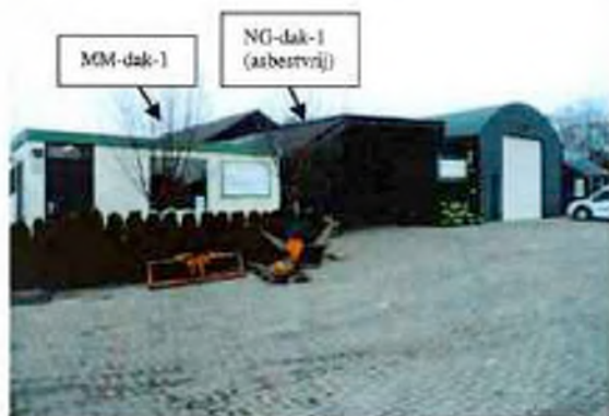
Foto 2: Geïntervieweerde schuur 1 waaronder romneyloods en kantoorunit vanuit noordoostelijke richting gezien. Dakbedekking is gedeeltelijk asbesthoudend en gedeeltelijk asbestvrij. (zie foto 3 en 4)
