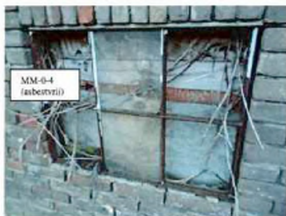
Foto 8: Asbestvrije stopverf in raamkozijnen van schuur 3.
