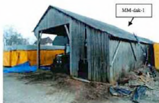
Foto 1: Geïntervieweerde schuur 1 met asbesthoudende golfplaat als dakbedekking vanuit zuidelijke richting gezien.
