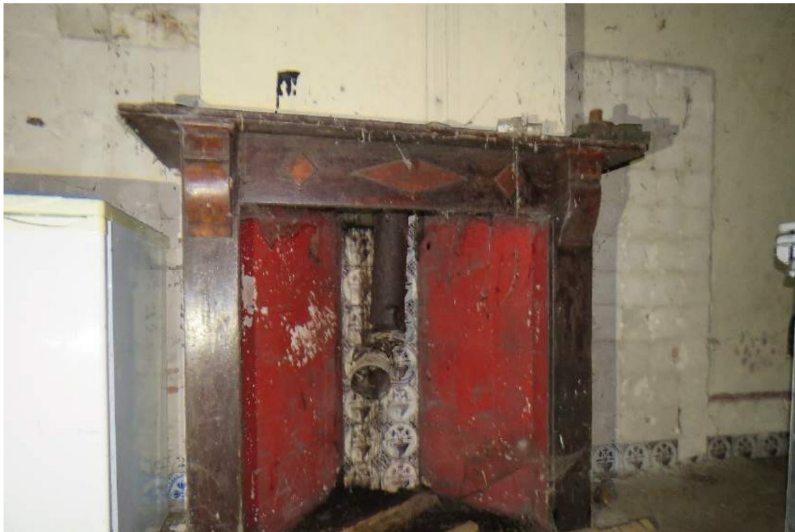
Schouwpartij in het voorhuis. Rechts zijn (waarschijnlijk fraaie) tegels verwijderd.
