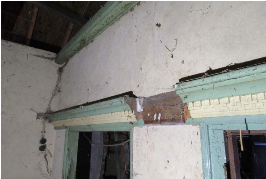
Er zijn nog enkele fraaie betimmeringen aanwezig in het voorhuis.
